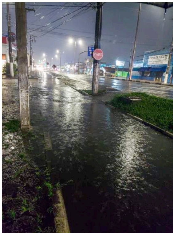
Figura 4 - Trecho da ciclovia de Caraguatatuba, paralelo a Avenida Rio Branco, inundada pela água da chuva. Fonte: Autor, tirada em 18 de out. de 2021.
