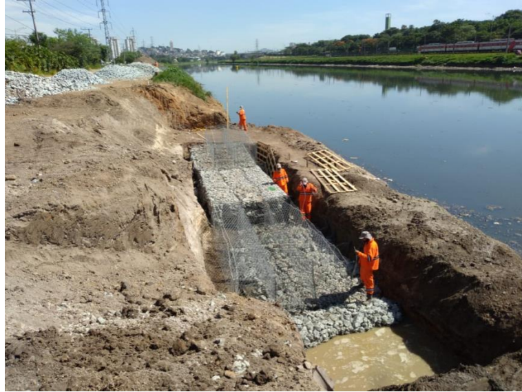
Figura 1 - Gabiões tipo caixa sendo instalados nas margens do rio Pinheiros, na cidade de São Paulo.
