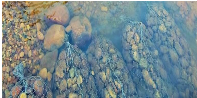
Figura 3 - Gabiões tipo saco assentados no leito do rio.
