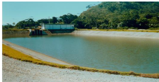
Figura 6 - Captação do Baixo Rio Claro. Fonte: SABESP (2007).
