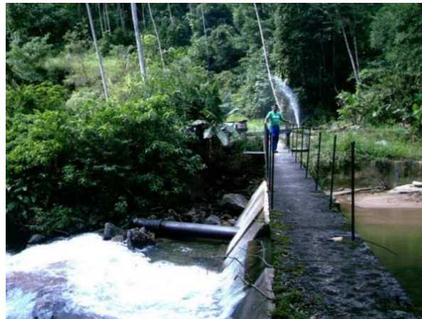
Figura 5 – Captação do Alto Rio Claro. Fonte: SABESP (2007).
